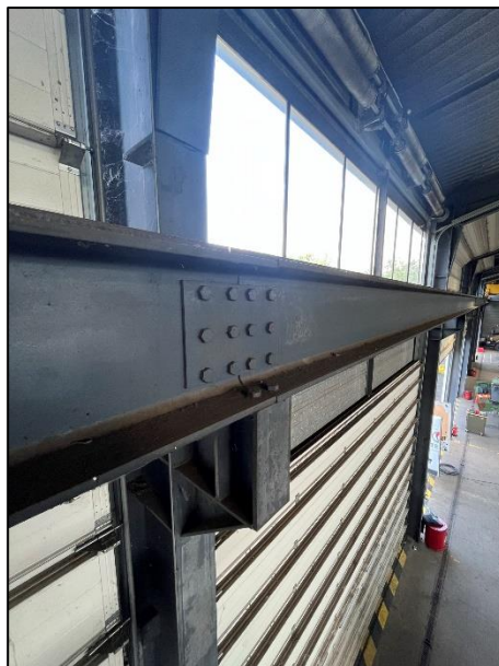
Poutre du pont roulant sur appui
