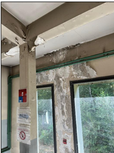
Infiltrations dans le bâtiment
