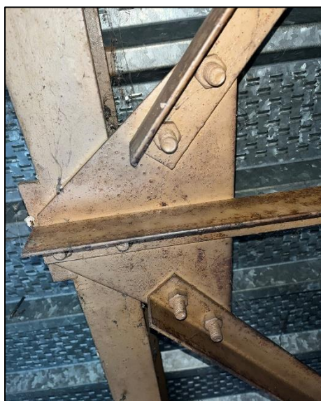
Assemblage contreventement (Détail 2)
