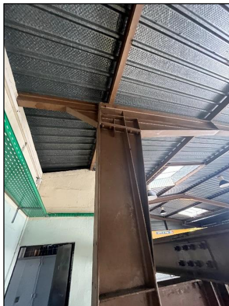
Détail de l'assemblage arbalétriers sur poteau en file B (Détail 1)
