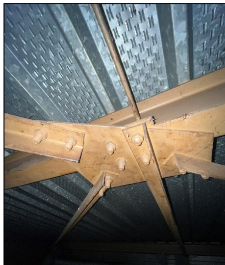
Assemblage contreventement
