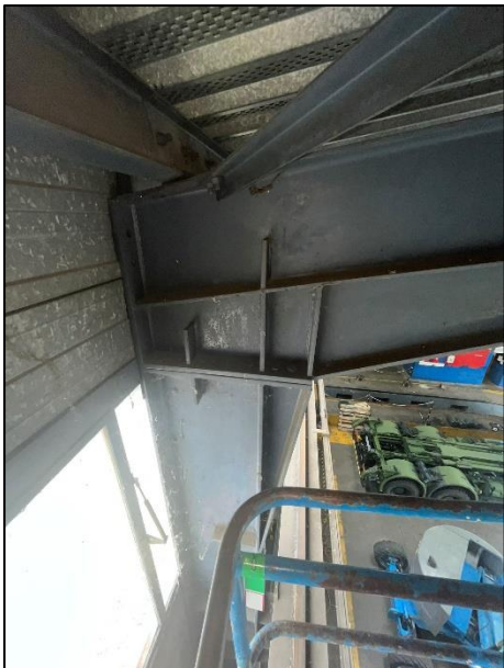
Détail de l'assemblage arbalétrier sur poteau (Détail 1)
