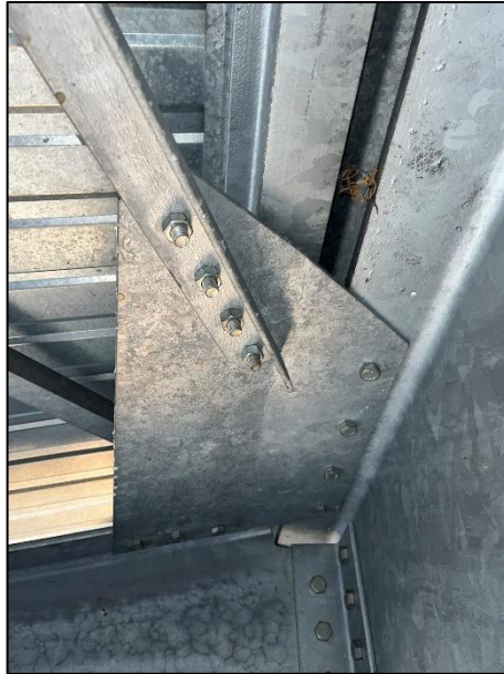
Assemblage contreventement
