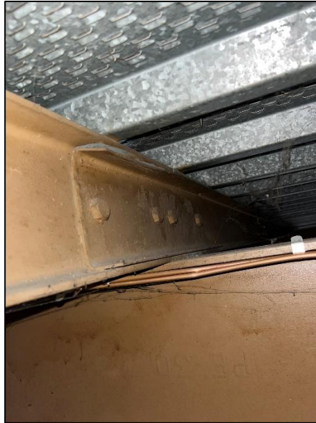
Assemblage pannes (Détail 4)
