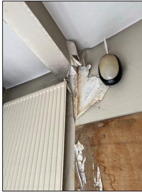
Infiltrations dans le bâtiment
