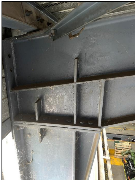
Détail de l'assemblage arbalétrier sur poteau (Détail 1)
