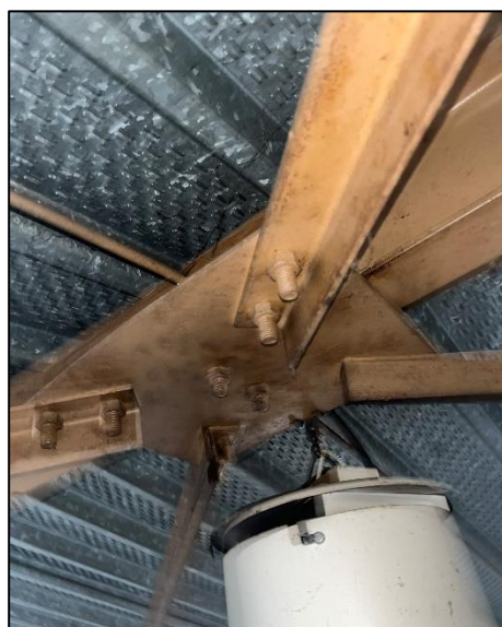
Assemblage contreventement (Détail 3)
