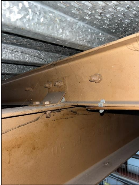
Assemblage pannes (Détail 4)
