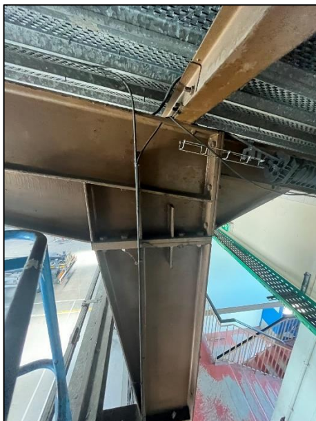
Détail de l'assemblage arbalétriers sur poteau en file B (Détail 1)
