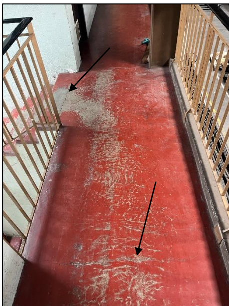
Fissures en surface de dalle
